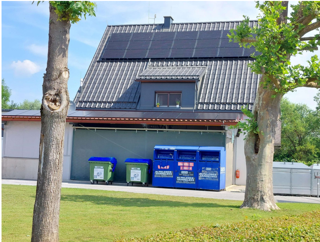
PVA - Dach Wirtschaftshof (13 kWp)
