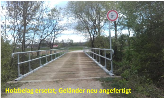
Holzbelag ersetzt, Geländer neu angefertigt
